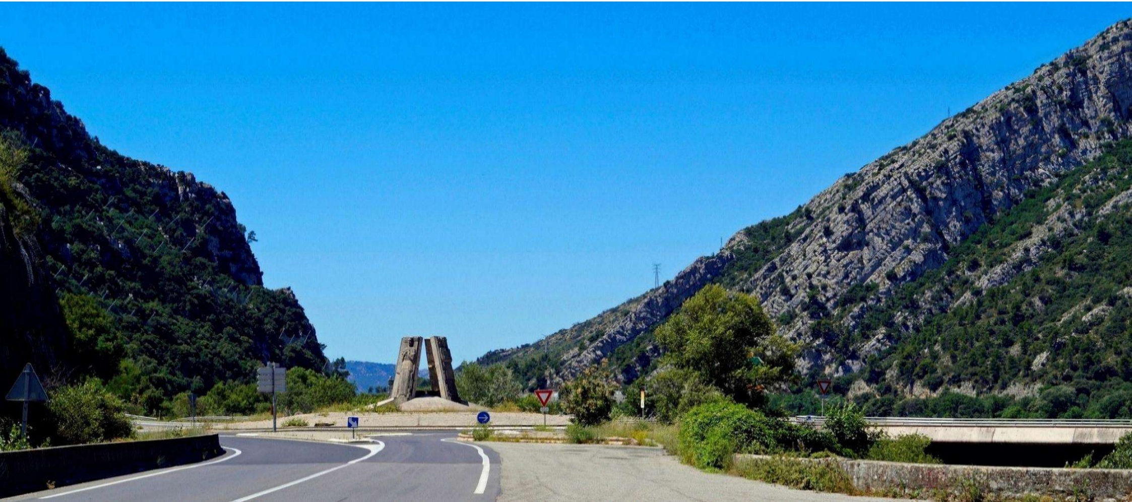
Kreisverkehr an der Durance Brücke
